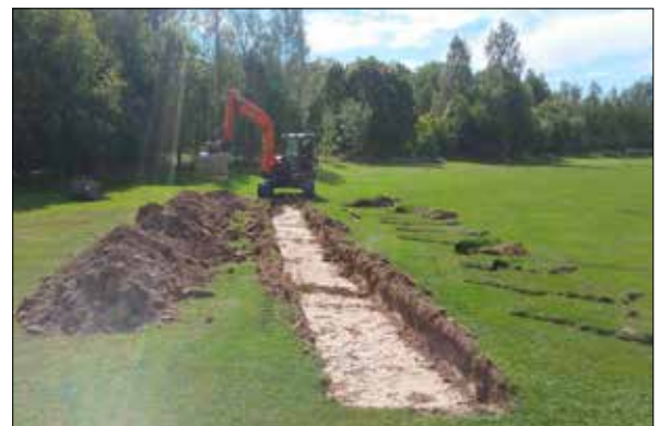
Schakt 13 fotograferat mot söder. Foto: Lars Norberg 2016, Sörmlands Arkeologi AB.
