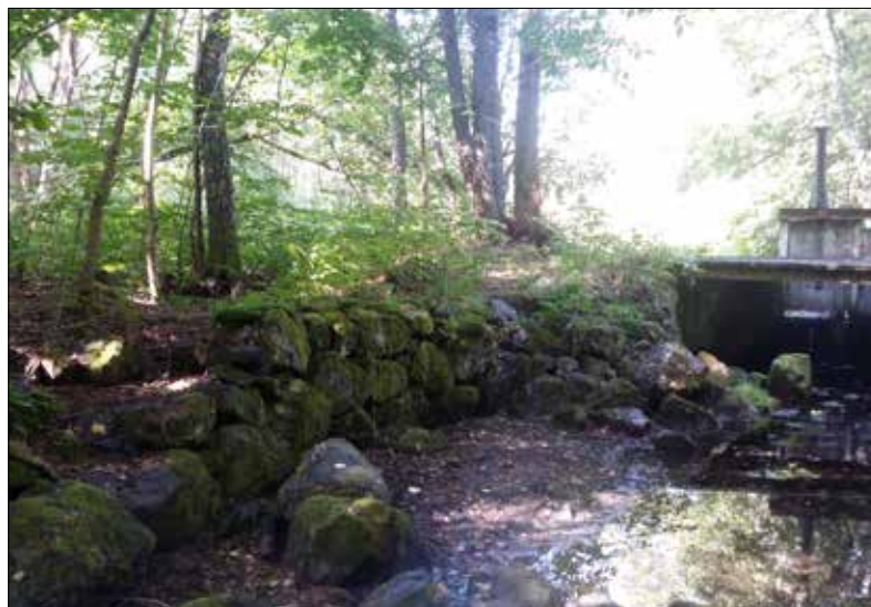
Objekt 23 /Husby-Rekarne 235 & objekt 21/ 43:1, ett dämme och en kanal fotograferade mot västnordväst. Foto: Lars Norberg 2016, Sörmlands Arkeologi AB.
