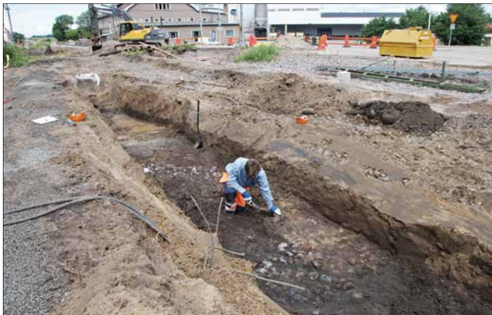
Fig 34. Rikard Hedvall sitter mitt på Sprättegatans yngsta stenbeläggning. Bakom grävmaskinen löper Linköpingsgatan. Här löpte tidigare järnvägsspåret. FOTO RAÄ, UV ÖST.
