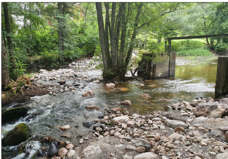
Slutresultat nedströms dämnet med utlagd grus och sten. Arbetsvägen som syns på bild på sida 15 är nu borta. Bilden är tagen från nordnordväst. Foto: Patrik Gustafsson Gillbrand 2022, Sörmlands Arkeologi AB.
