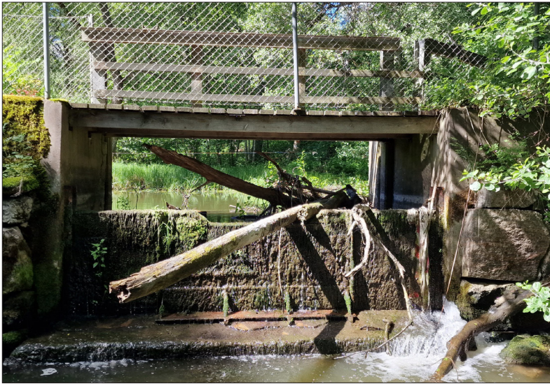
En av damluckorna innan rivning. Bilden är tagen från nordöst. Foto: Lars Norberg 2022, Sörmlands Arkeologi AB.
