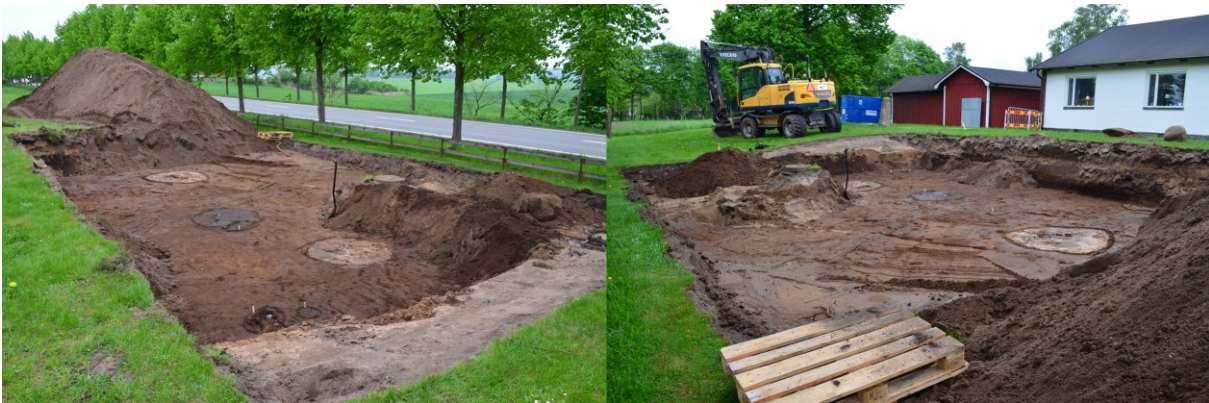
Fig. 8. Ytan för infiltrationsbädden avschaktad och rensning pågår. Fotot till vänster taget mot sydväst och fotot till höger taget mot nordost.
