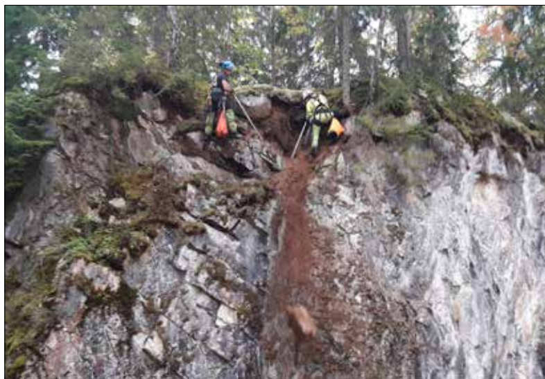
Figur 10. Vid säkringen av bergväggarna utfördes arbetet med spett och fyllhammare, varvid sten lösgjordes. Bilden är tagen från nordöst. Foto: Patrik Gustafsson Gillbrand 2017, Sörmlands Arkeologi AB.
