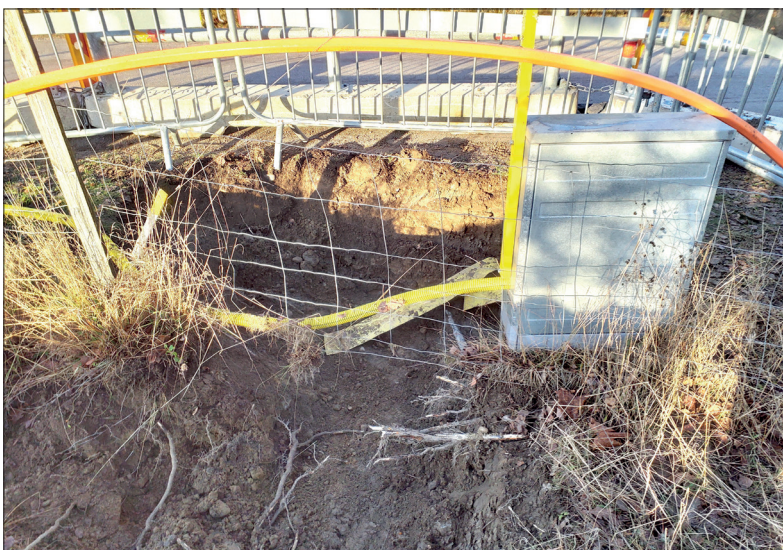
Översikt av schaktet vid elskåpet. Bilden är tagen från söder. Foto: Patrik Gustafsson Gillbrand 2024, Sörmlands Arkeologi AB.
