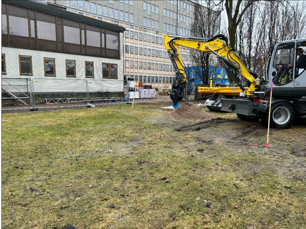
Figur 7. Översiktsbild av ytan för schakt 1 innan undersökningen påbörjades. Foto från nordost.
