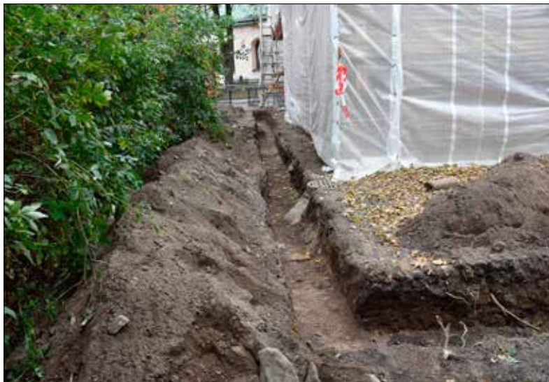
Figur 12. Öppnat fjärrvärmeschakt mellan Westerlingska gården och Mårtenshuset (till höger). Foto mot nordnordväst: Lars Norberg år 2016, Sörmlands Arkeologi AB.
