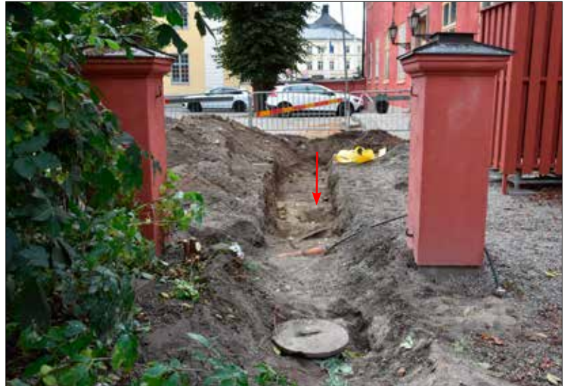
Figur 11. Öppnat fjärrvärmeschakt framför entrén till Westerlingska gården. Platsen för myntfyndet (F1) markerat med röd pil. Foto mot sydväst: Lars Norberg år 2016, Sörmlands Arkeologi AB.
