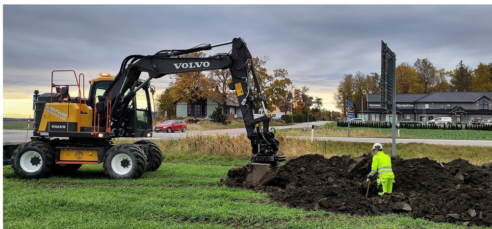
FIGUR 3. Sökschaktning pågår.
