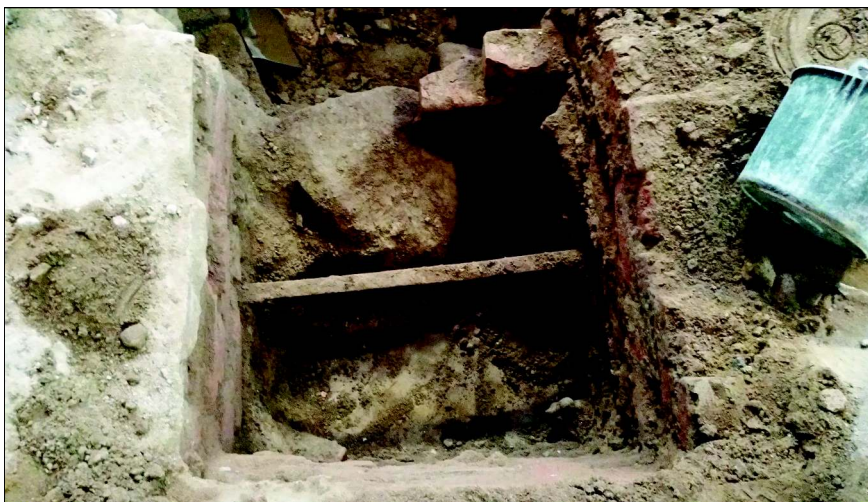
Figur 5. I den västra delen av trapprummet fanns två stenar som eventuellt inte tillhörde kryptans konstruktion. Istället kan de ha ingått i 1100-talskyrkans östra vägg. I bild kan man också se den järnbalk som ingick som en del av trappväggarnas konstruktion. Bilden är tagen från väster. Foto: Patrik Gustafsson Gillbrand 2015, Sörmlands Arkeologi AB.
