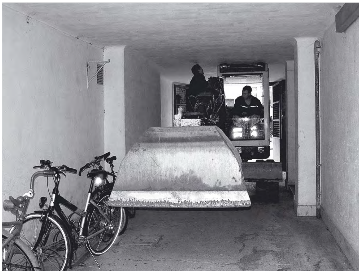
Fig. 3. Det var ett närmast vetenskapligt projekt att få in grävmaskinen till undersökningsområdet i S:t Görän 3. Som minst skiljde det 5 millimeter mellan maskinen och portens tak. Foto från väster: Mathias Bäck (U4602_2).
