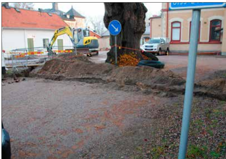
Figur 1. Översikt över Flickskolans gård med det öppnade schaktet. Bilden är tagen från sydväst. Foto: Patrik Gustafsson Gillbrand 2016, Sörmlands Arkeologi AB.
