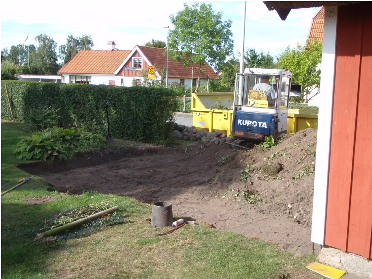
Fig. 3. Schaktning av matjord inom den aktuella undersökningsytan. Foto åt sydväst.
